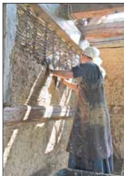
Das Museum gewährt auch Einblicke in den Aufbau einer Lehmwand oder in die Konstruktion eines Fachwerkbau mit den Materialien, Werkzeugen und Methoden von damals.
